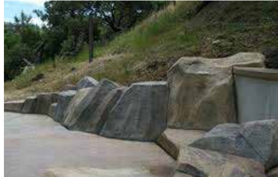
Stoðvegur myndaður úr sprengdu grjóti.
