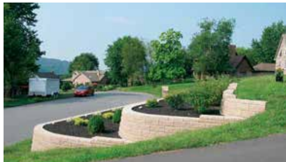
Stoðvegur brotinn upp með gróðurbeði á milli
