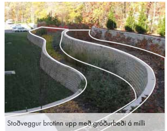
Hæðarmismunur tekinn niður með tveimur stoðveggjum og gróðurbeði á milli.
