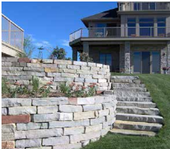
Mikill hæðarmunur brotinn upp með stoðveggjum og gróðri á milli.
