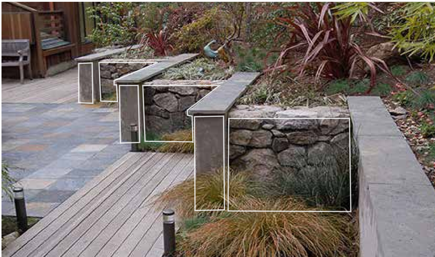
Stoðveggur með blandaðri efnisnotkun. Hlaðið grjót og steyptar einingar. Lágur gróður í beði fyrir ofan stoðvegg.
