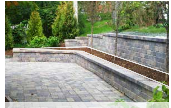
Hæðarmismunur tekinn niður með tveimur stoðveggjum og gróðurbeði á milli.
