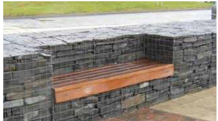
Bekkur byggður inn í gabion vegg.
